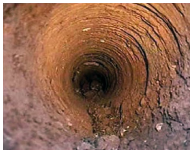
Blick in das Bohrloch
